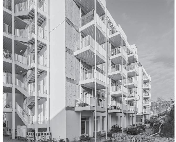
der Fassade geführte Regenrohre abgeführt, bei den vorgesetzten versteckt in den U-Profilen ihrer Stützen. Beide Varianten erhielten jedoch in ihrer Untersicht weiße Trapezbleche, um sich von den Baukörpern klar abzusetzen, und laden zur Entdeckung ihres vielfältigen Lebens ein.
