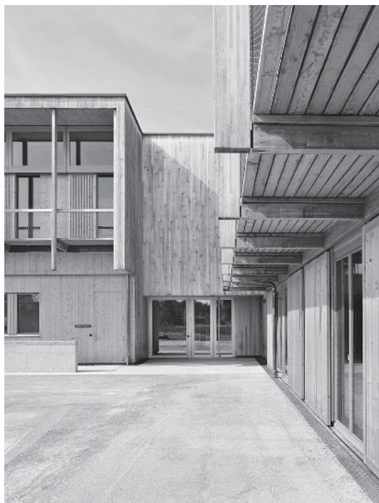
und ist mit Schlitzblechen auf Abstand an den Hängestützen bzw. der Fassade montiert. Tropfkanten an den empfindlichen Stellen und eine sorgfältig ausgeführte Abdichtung schützen vor eindringender Feuchtigkeit. Ein Blick auf die Ausführung verdeutlicht das besondere Augenmerk, das den einzelnen konstruktiven Elementen zuteil wurde. Es bildet die Grundlage für eine möglichst lange Lebensdauer dieser hier wohl durchdachten und nicht nur als Raumerweiterung umgesetzten Balkonstruktur.
