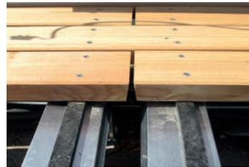
Längsstoßausbildung zwischen zwei Unterkonstruktionen mit offener Fuge zur Vermeidung von Staunässe im Hirnholzbereich
