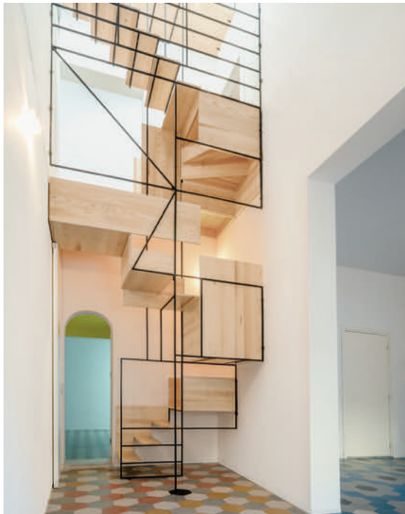
Zusammengesetzt aus hölzernen Flächen und hölzernen Boxen, getragen von einem Metallgerüst: Zu begehen ist diese Treppenskulptur in einem sanierten Fischerhaus auf Sizilien.
