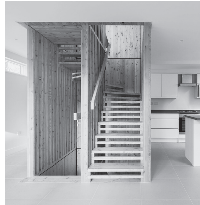
Waind Gohil and Potter Architects entwarfen für ein Haus in London eine Wangentreppe aus vorfabrizierten Massivholzelementen mit einer Decklage aus Lärchenholz.
