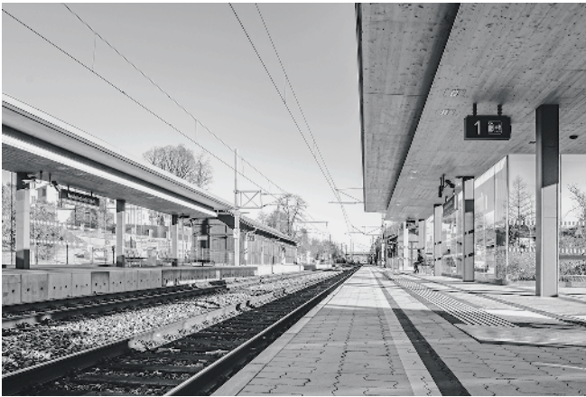
Bahnhof Neulengbach, mohr niklas architekten, 2021
