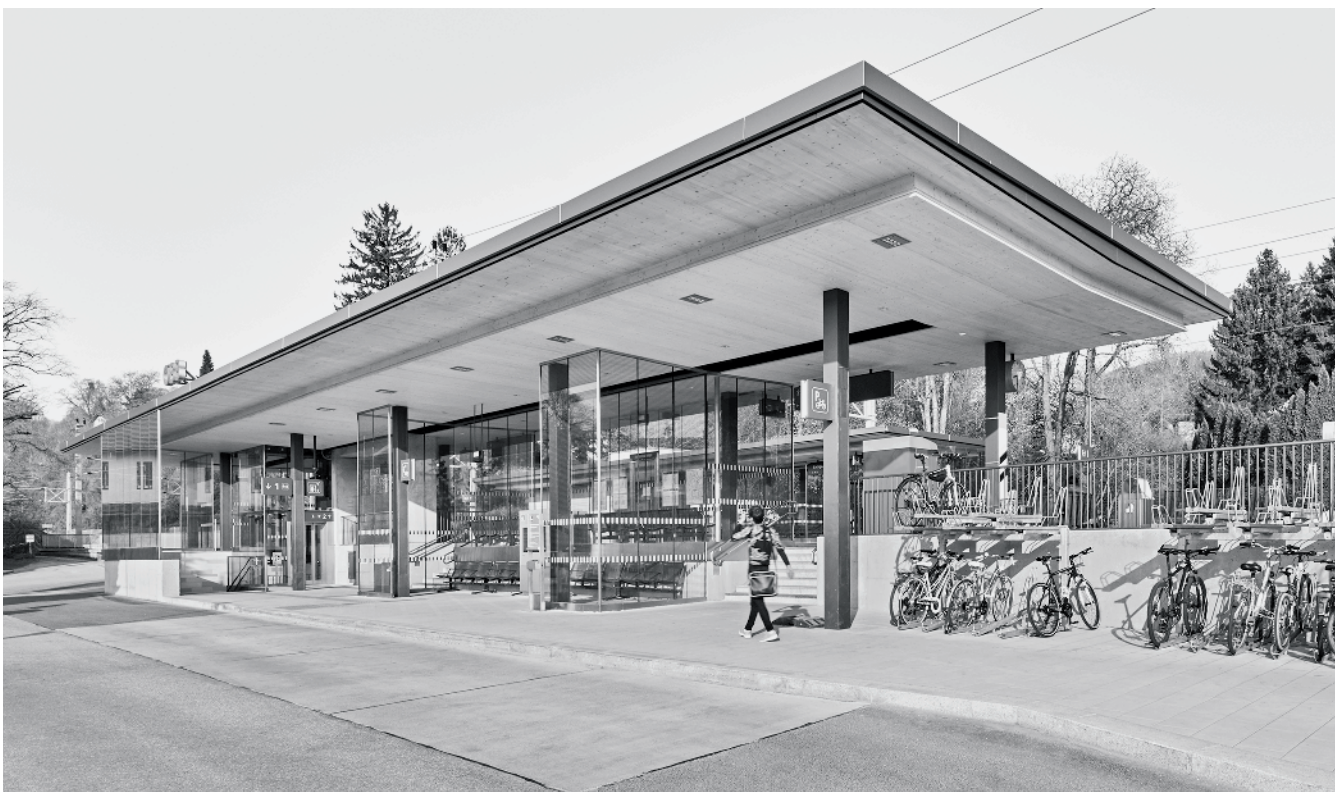
Sanierung der Haltestelle Eichgraben-Altengbach, mohr niklas architekten, 2017
