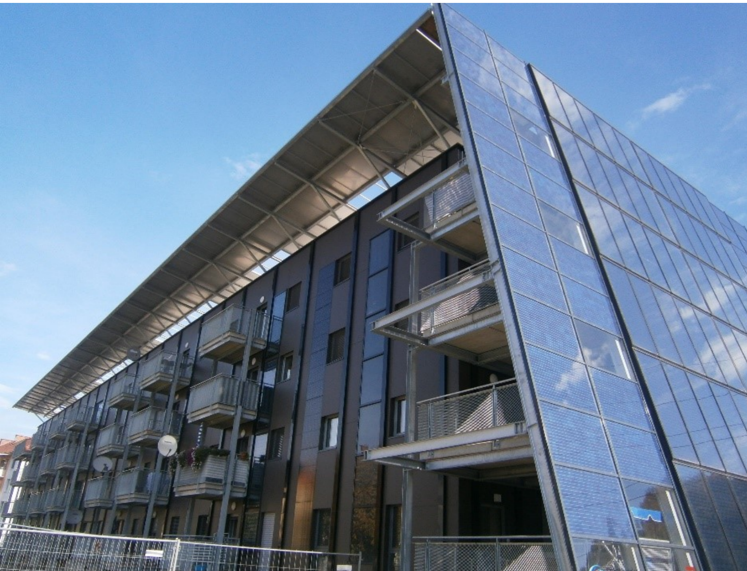
Plusenergiesanierung Wohnbau Kapfenberg, Arch Nussmüller & AEE INTEC, 2014 © AEE INTEC
