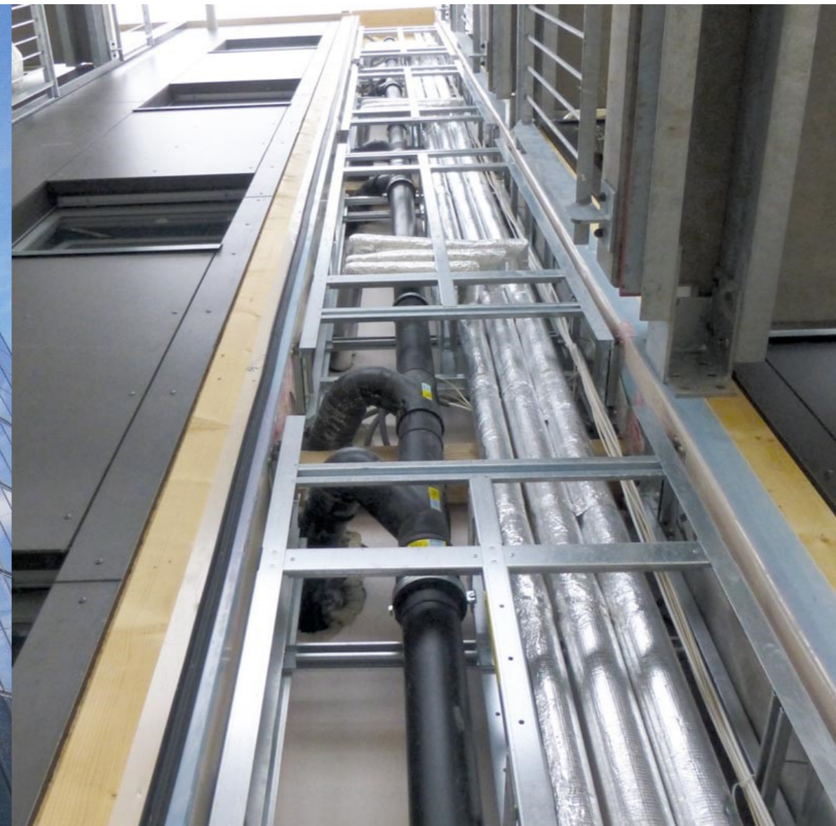
Plusenergiesanierung Wohnbau Kapfenberg, Arch Nussmüller & AEE INTEC, 2014 © AEE INTEC
