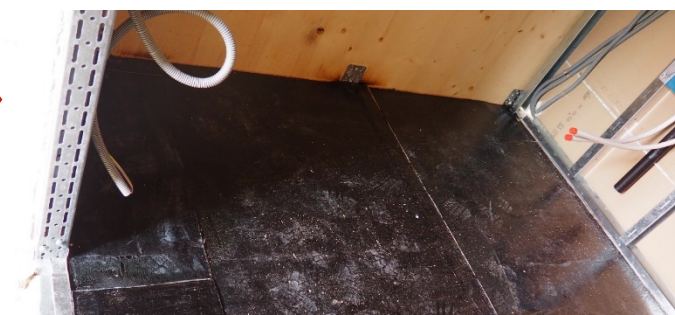
Bitumenbahn SK mit Hochzug
