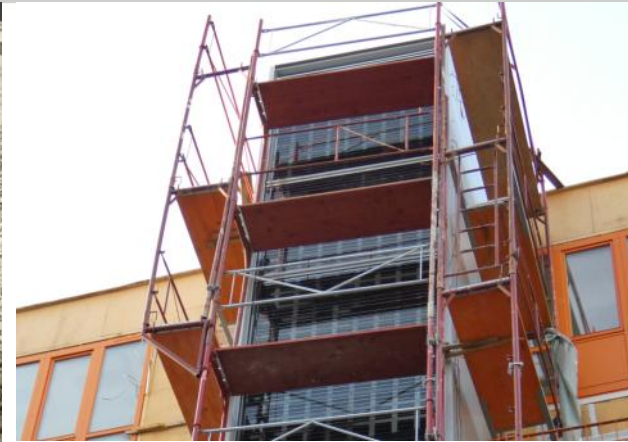
... transparente PV-Module als Sonnenschutz
