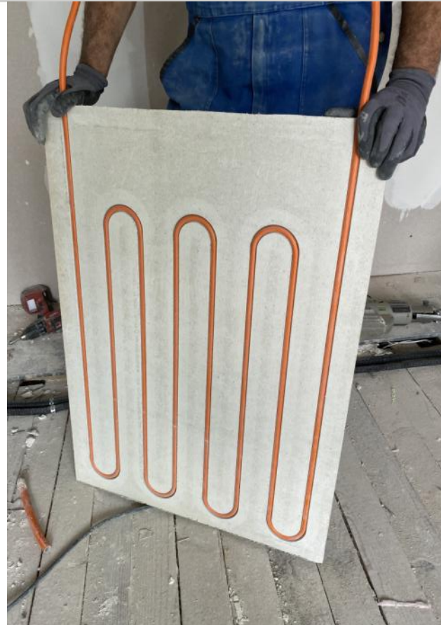
Solarmatten als sommerliche Energiekollektoren
