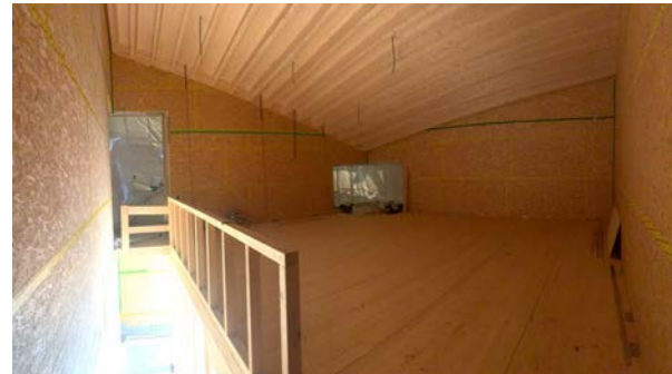
Baustelle Neubau Fahrschule Kern, Mattighofen, OÖ
