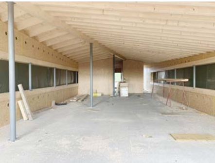
Baustelle Neubau Bürogebäude Linecker, Höhhart, OÖ
