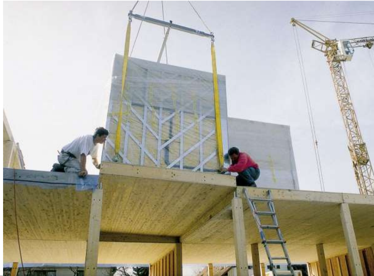
VORFERTIGUNG WOHNBAU PASSIVHAUS
