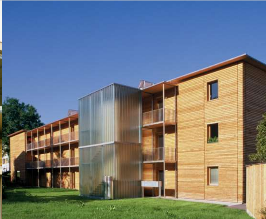
VORFERTIGUNG WOHNBAU PASSIVHAUS
