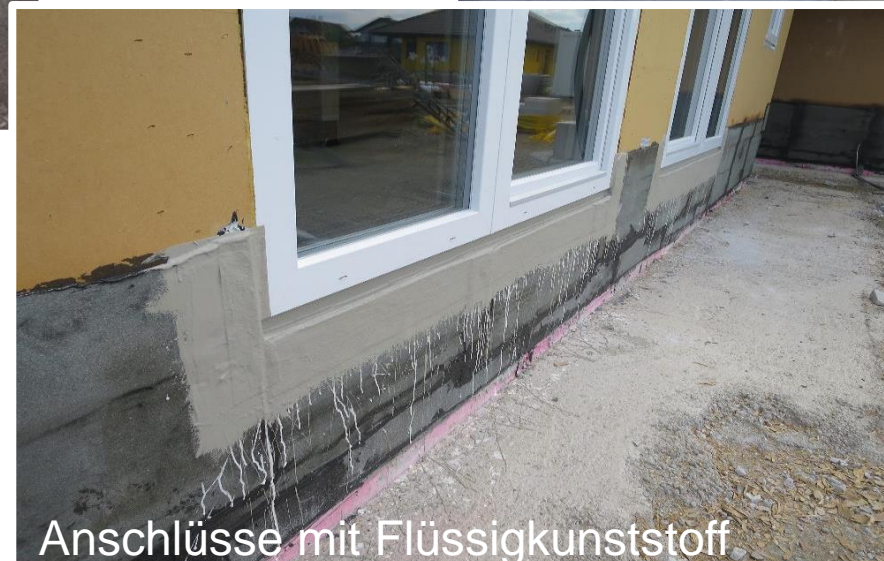
Stauwasserdicht verklebte Anschlussbahnen
