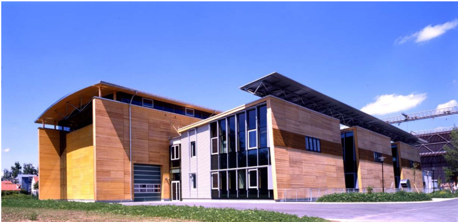
Bautechnikzentrum TU-Graz, Nussmüller Architekten 2001
