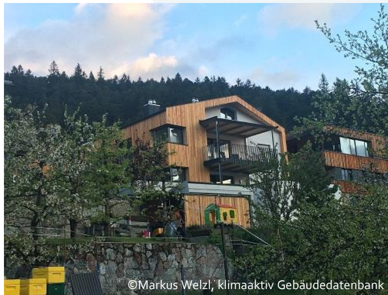
Mehrfamilienhaus Welzl, klimaaktiv Bronze Sanierung
