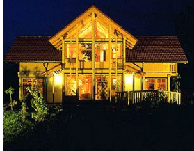
Solares Niedrigenergiehaus Wabelsdorf 1993
