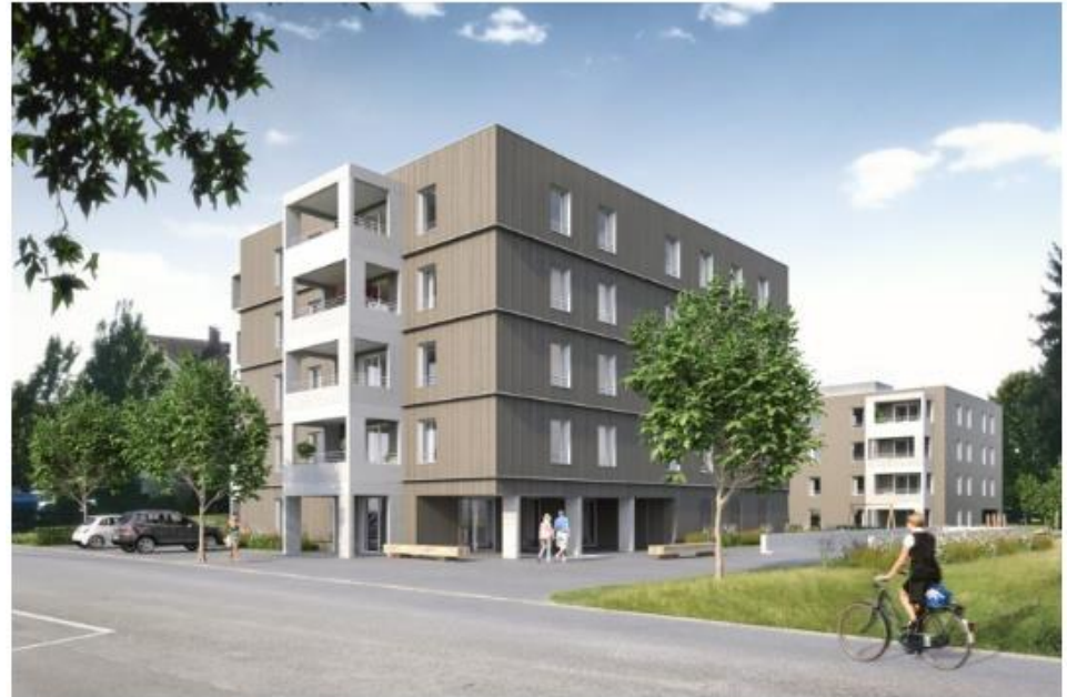
Zwei Wohnbauten in der Wolfurter Lerchenstraße: Architektonisch weitgehend ident, macht der Unterschied der Bauweise einen gravierenden Unterschied, wie aktuelle Ergebnisse zeigen.
