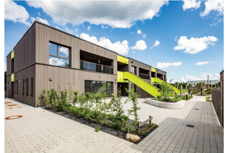
Diese Kita von werk.um architekten im Landkreis Bergstraße wurde als Holzbau errichtet. Foto: Thomas Ott
