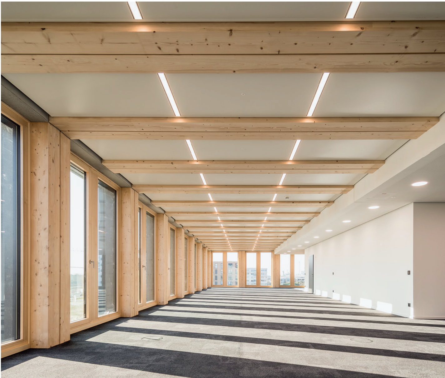
Im Handwerkerhaus Bremen ist die Holztragstruktur im Inneren sichtbar.
